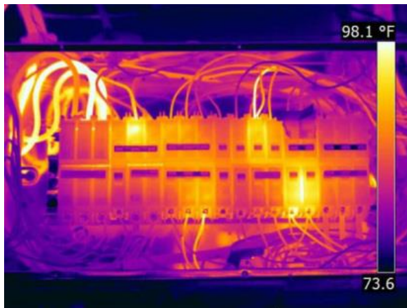
Kuva 9 Sähköpääkeskuksen lämpöero (Flir)
