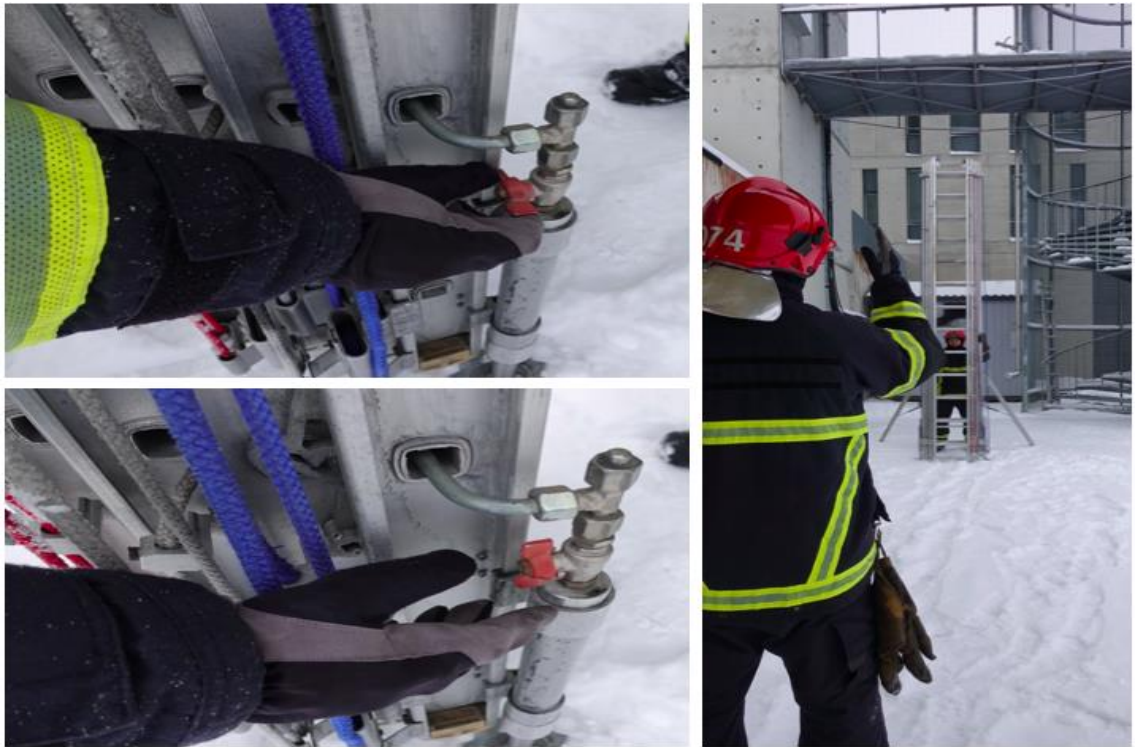
Kuva 22. Kakkosen tukiessa tikasta ykkönen avaa pinnantasauslaitteiston hanan. Ykkönen antaa kakkoselle ohjeita siitä, mihin tikkaita kallistetaan.
