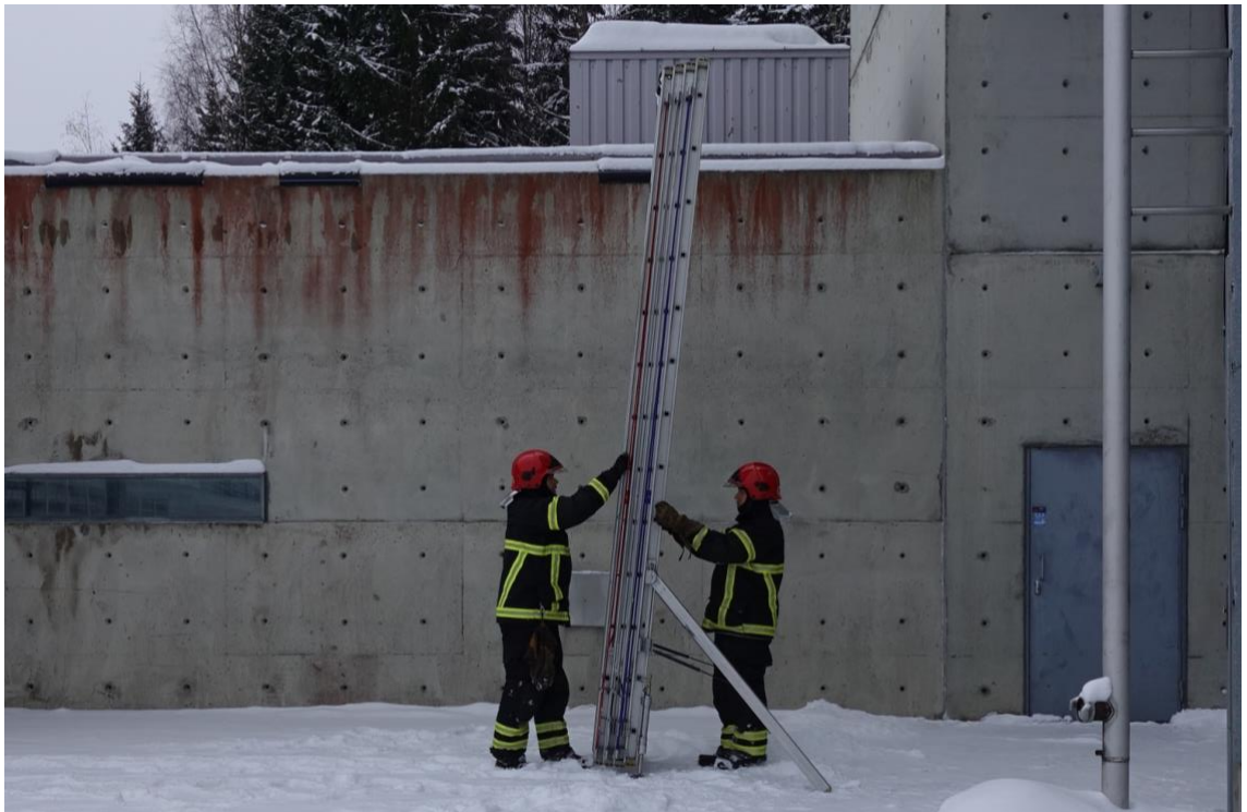
Kuva 21. Tikkaat nostetaan tukijalkojen varaan kakkosen jäädessä tukemaan tikkaita.
