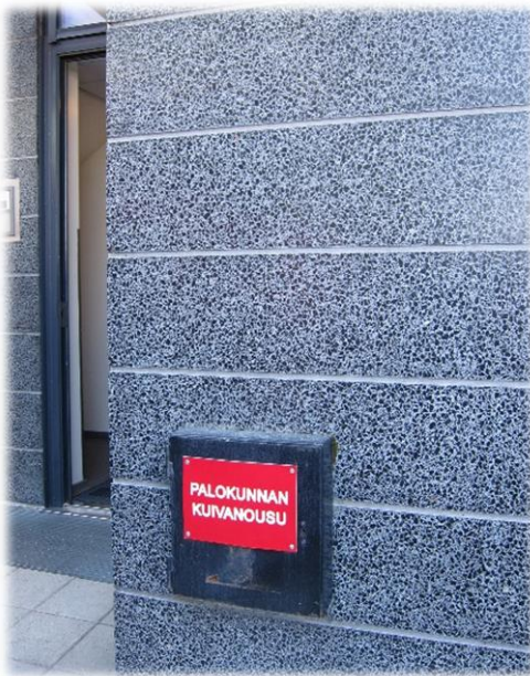
Kuva 64. Vasemmalla nousujohtojen syöttö on rakennuksen ulkoseinässä, oikeassa kuvassa syöttö on rakennuksen sisällä (Latvala).
