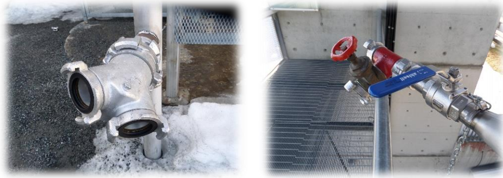
Kuva 12. Vasemmalla vuoroliitin nousujohdon syöttöyhteessä, oikealla oksaliitin nousujohdon ulosotossa (Pelastusopisto).
