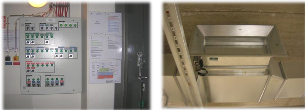
Kuva 53. vasemmalla koneellisen savunpoiston ohjauskeskus. Oikealla kuvassa on koneellisen savunpoiston imukanava ja imupiste ohjattavalla savunhallintapellillä. (Pelastusopisto)
