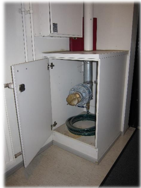
Kuva 64. Vasemmalla nousujohtojen syöttö on rakennuksen ulkoseinässä, oikeassa kuvassa syöttö on rakennuksen sisällä (Latvala).
