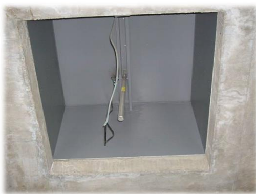
Kuva 52. Vasemmalla kuvassa porrashuoneen keltainen savunpoiston laukaisupainike, oikealla savunpoistoluukku porraskäytävän katossa (Pelastusopisto).
