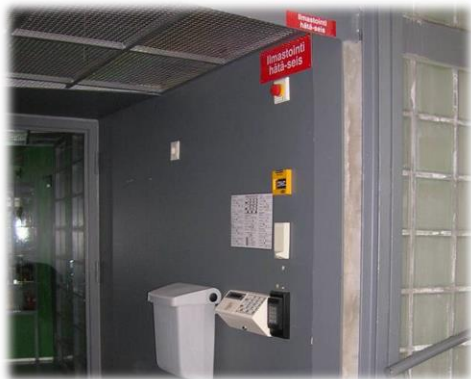
Kuva 52. Vasemmalla kuvassa porrashuoneen keltainen savunpoiston laukaisupainike, oikealla savunpoistoluukku porraskäytävän katossa (Pelastusopisto).
