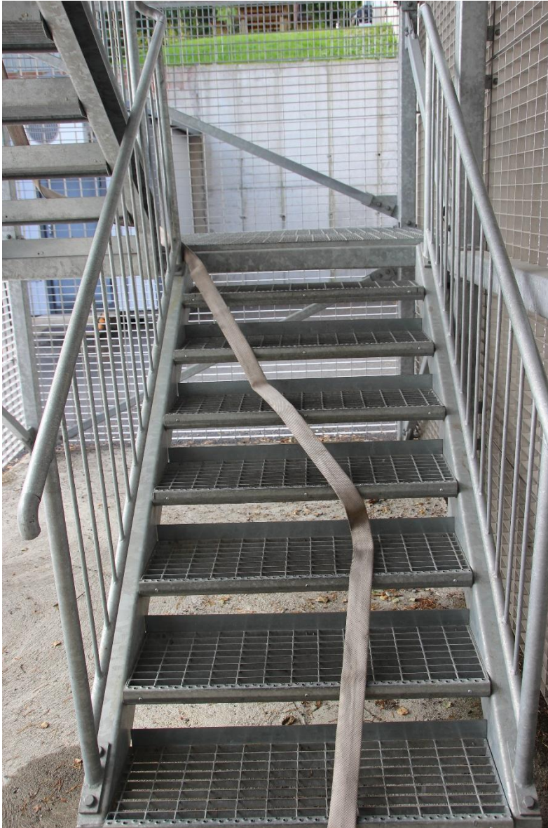
KUVA 25. Työjohton suuntautuminen portaikon sisäkehälle (kuva: Sami Pelkonen)
