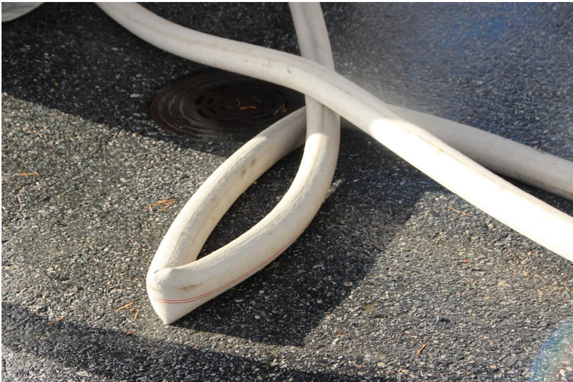
KUVA 22. Mutka toisessa pääjohdossa autopumpun ja vuorajakoliittimen välillä (kuva: Sami Pelkonen)
