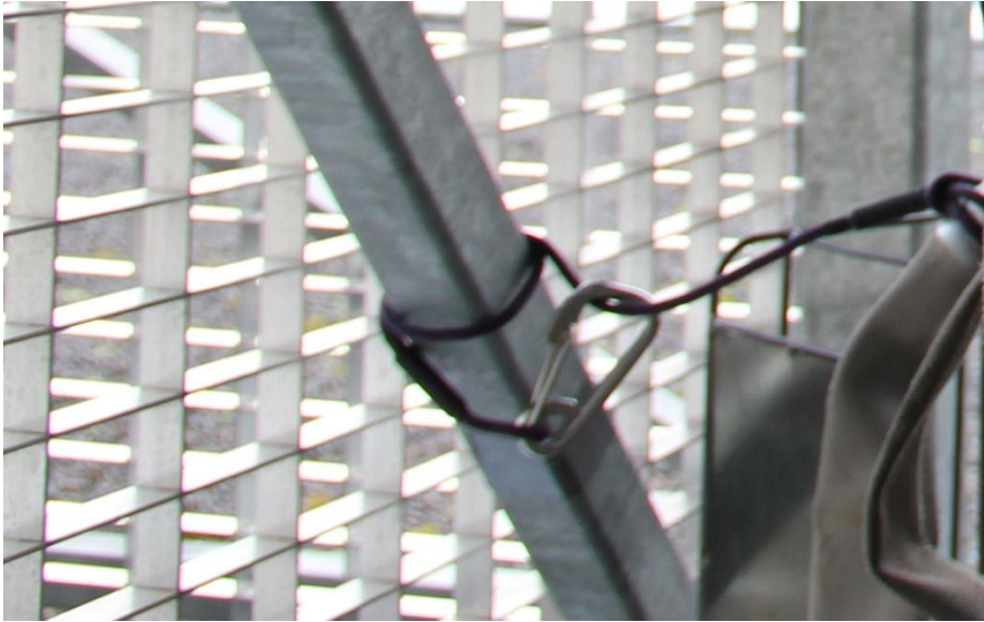
KUVA 7. Työjohto sidottuna letkunkannattimella
