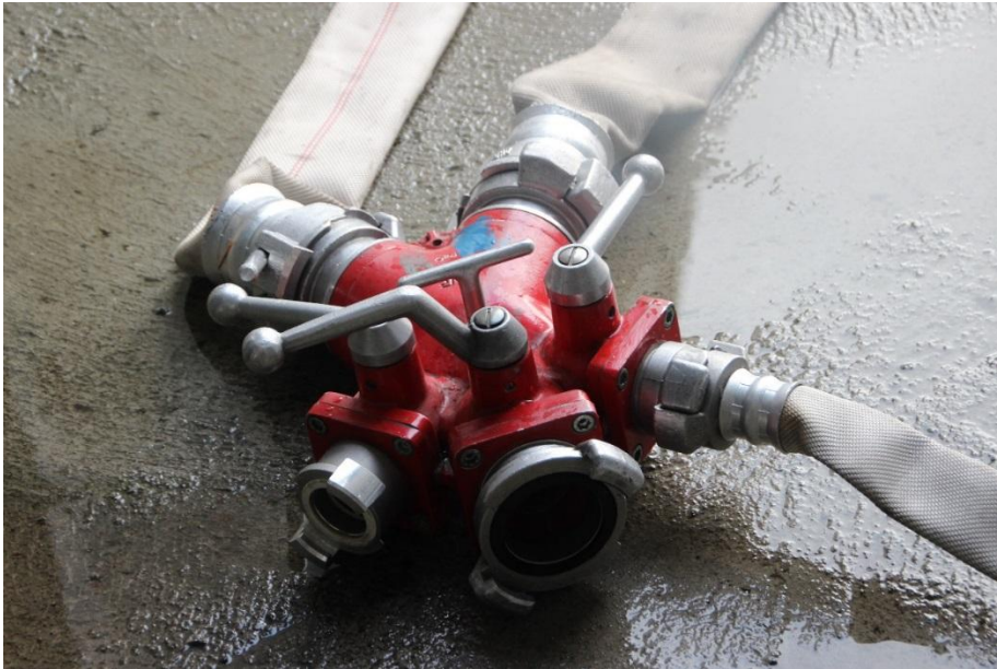
KUVA 24. Työjohto on liitetty vuorjakoliittimen vasemmanpuoleiseen haaraan (kuva: Sami Pelkonen)
