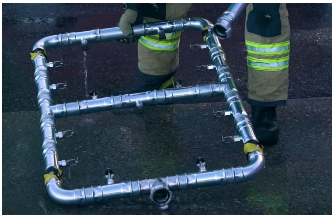
Kuva 33. Alustasprinkleri. Kuva: Palosuojelurahasto
